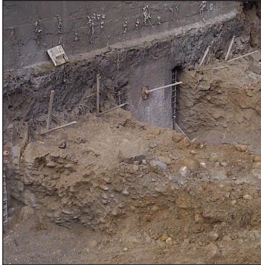
Détail d'une reprise en sous-œuvre (Doc. http://legeotechnicien.blogspot.fr )
