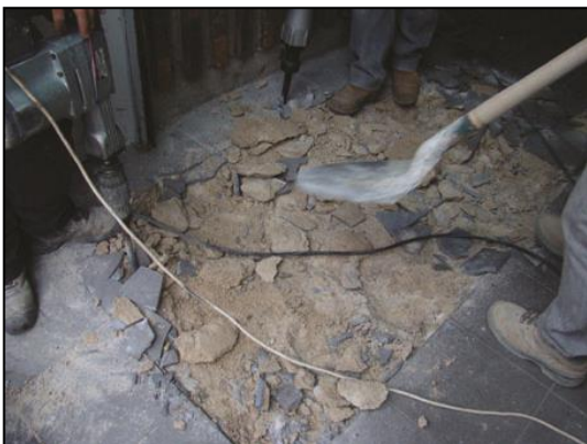
Mortier de pose en cours de démolition
