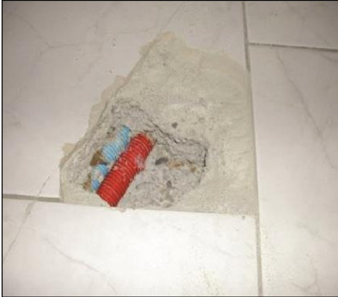
Fourreaux incorporés directement dans la chape
