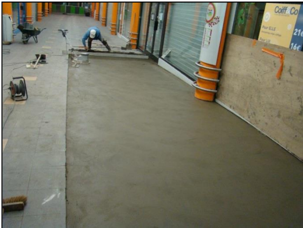
Réalisation de la chape support
