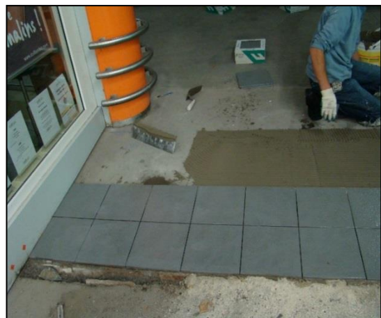
Pose collée du revêtement
