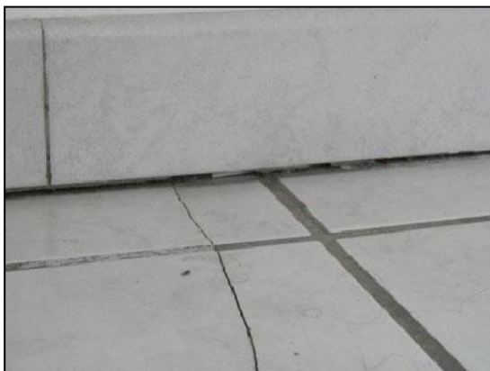
Affaissement du sol en périphérie des locaux
