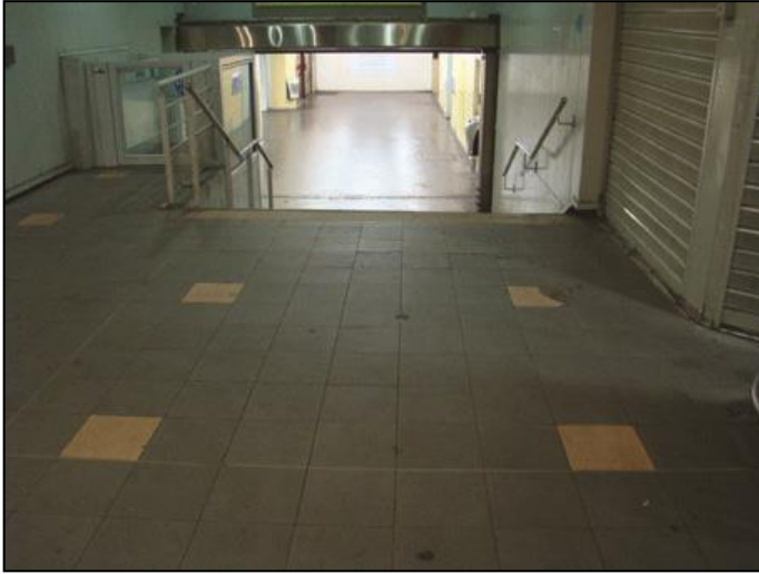
Cas particulier d'une galerie marchande -Vue d'ensemble du revêtement
