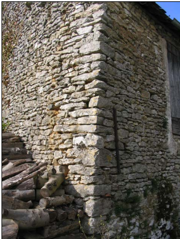
Exemple de murs en maçonnerie de moellons et de pierres de taille.
