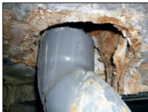
Traversée de canalisation mal réalisée : corrosion d'une gaine de ventilation située à l'aplomb de fuites non maîtrisées
