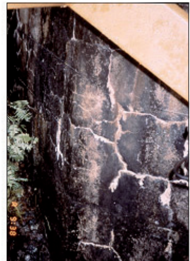
Conséquences des phénomènes d'alcali-réaction sur des éléments d'ouvrage en béton.
