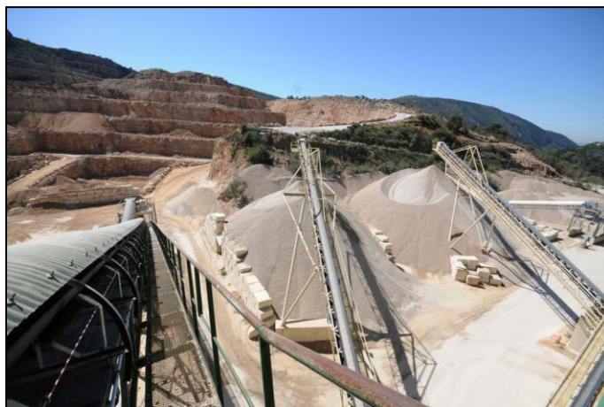
Carrière de roche massive - Stockage produits finis (Doc Audemard)
