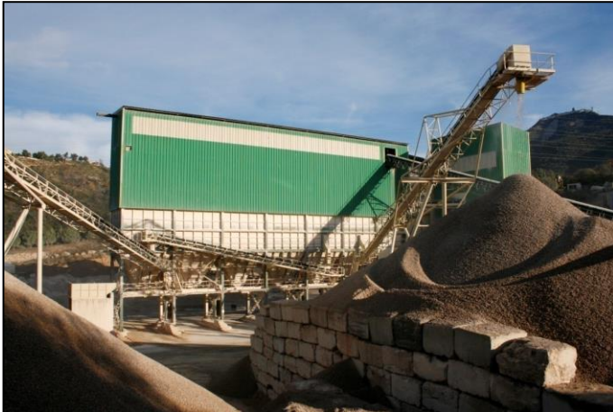
Installation de traitement de granulats issus de roches massives (Doc. Audemard)
